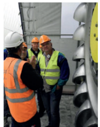
Eine Pelton-Turbine von Linth-Limmern wird revidiert.
