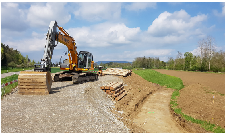
In Eschikofen hat die Sanierung des Thurdammes begonnen.
