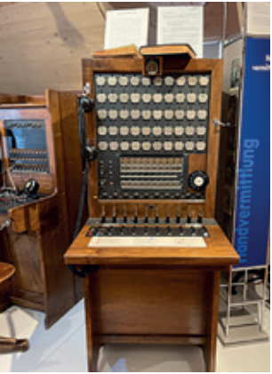
Telefonzentrale von dazumal
