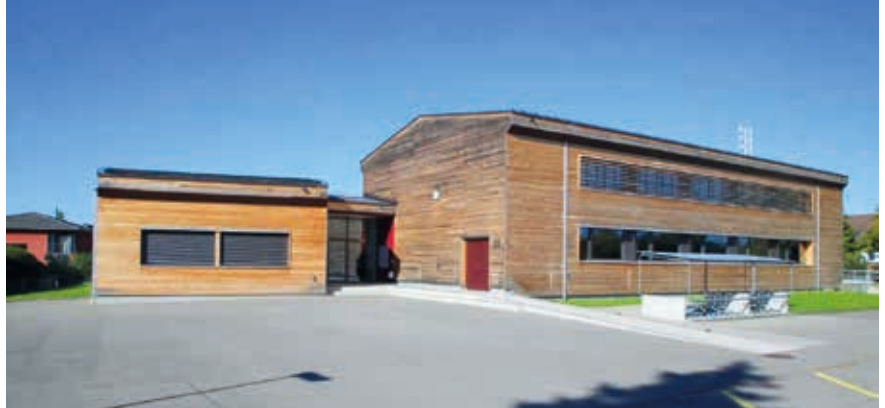
Die Mehrzweckhalle in Hüttlingen: Festzentrum bei den Feierlichkeiten zum 25-Jahr-Jubiläum. Bild Mario Gaccioli
