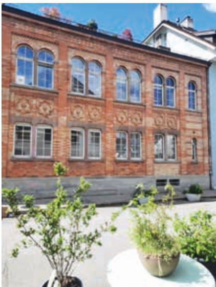
Bade- und Waschanstalt Das erste Hallenbad der Schweiz existierte von 1864 – 1915. Im Parterre standen 12 Badewannen, im 1. Stock das Hallenbad. Später diente es als Gantlokal und als Polizeiwache.
