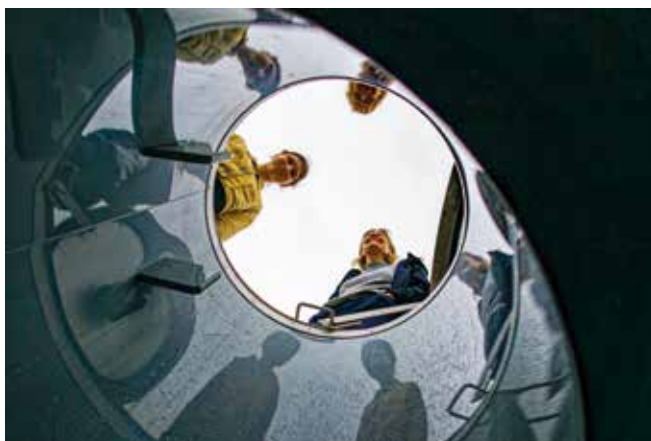
Blick ins Pumpwerk bei bedecktem Himmel.
