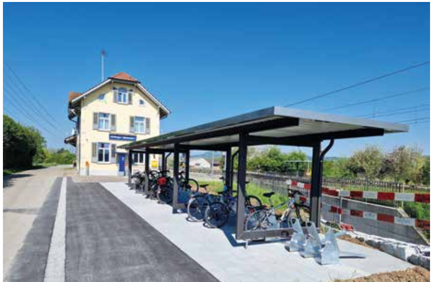
Die neue Veloabstellanlage beim Bahnhof Hüttlingen-Mettendorf.
